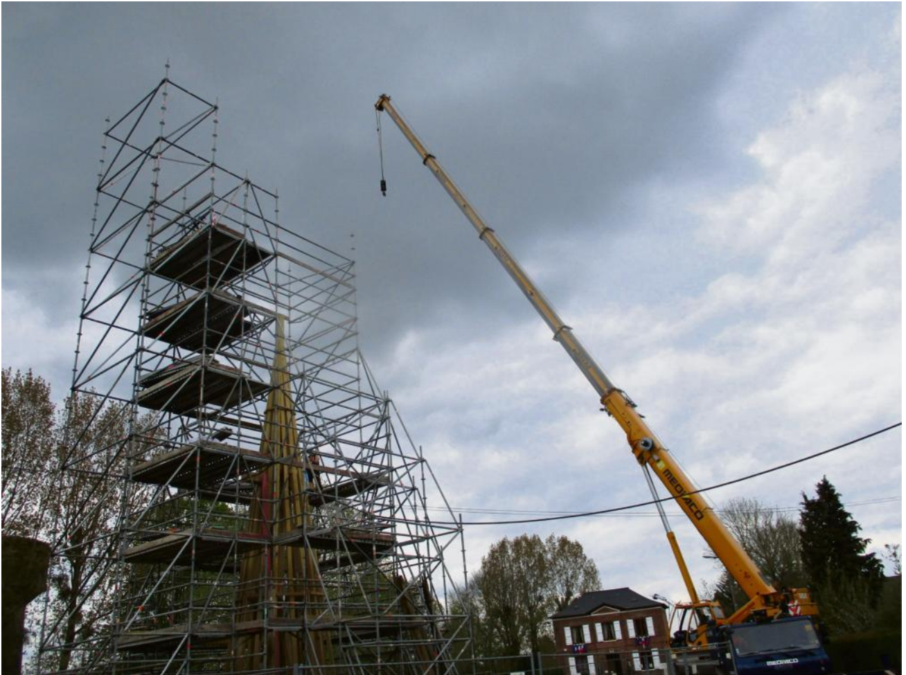
Le clocher, rebâti, a été provisoirement déposé sur un échafaudage (Photo Paris-Normandie)
