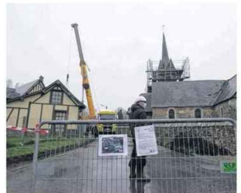
L'opération de dépose du clocher au sol a pris plusieurs heures.
