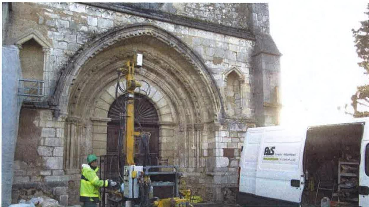
Sur le parvis, un nouveau forage a été réalisé à 20 m de profondeur pour tester la résistance du terrain.
