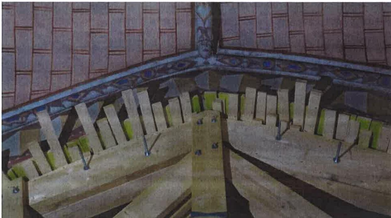
Au dernier étage de la charpente provisoire. La structure épouse la courbe des voûtes au plus près.
