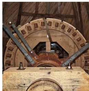
Le mécanisme a été refait à l'identique. © S.M.
