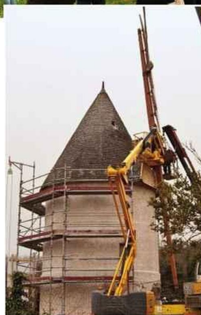
Les ailes ont été mises en place dans la foulée du recoiffage. © S.M.
