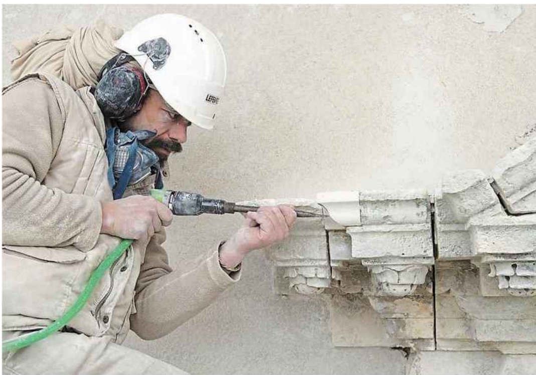
Les tailleurs de pierre ont remplacé les blocs trop abimés, pour redonner un coup de jeune à l'édifice de plus de 300 ans.
