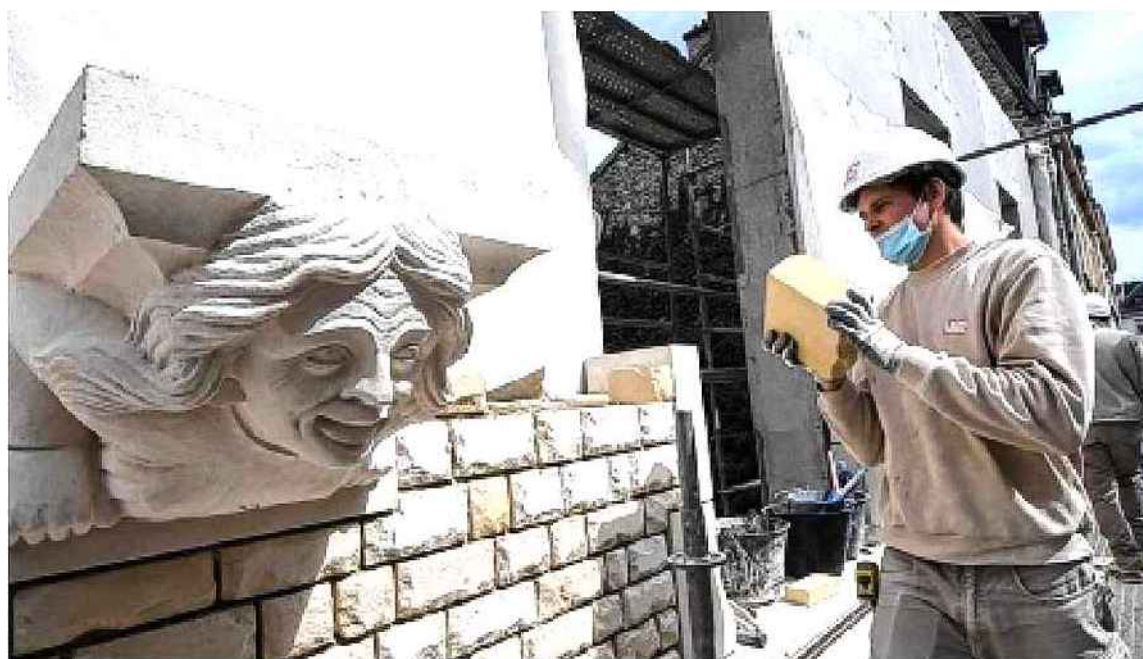
Les consoles taillées à la main, sur lesquelles reposeront les sculptures des musiciens et de l'auditeur, ont toutes été posées la semaine dernière. Hervé Oudin
