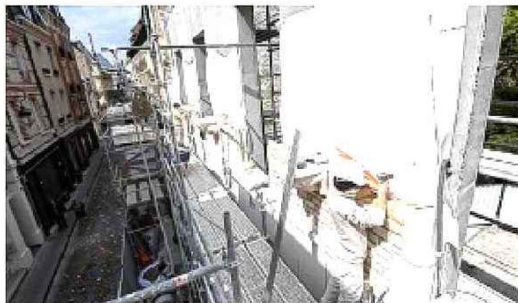
Actuellement, l'équipe de l'entreprise Léon Noël pose une multitude de pierres de formats différents, sur la façade qui est soutenue par un mur en béton. Hervé Oudin
