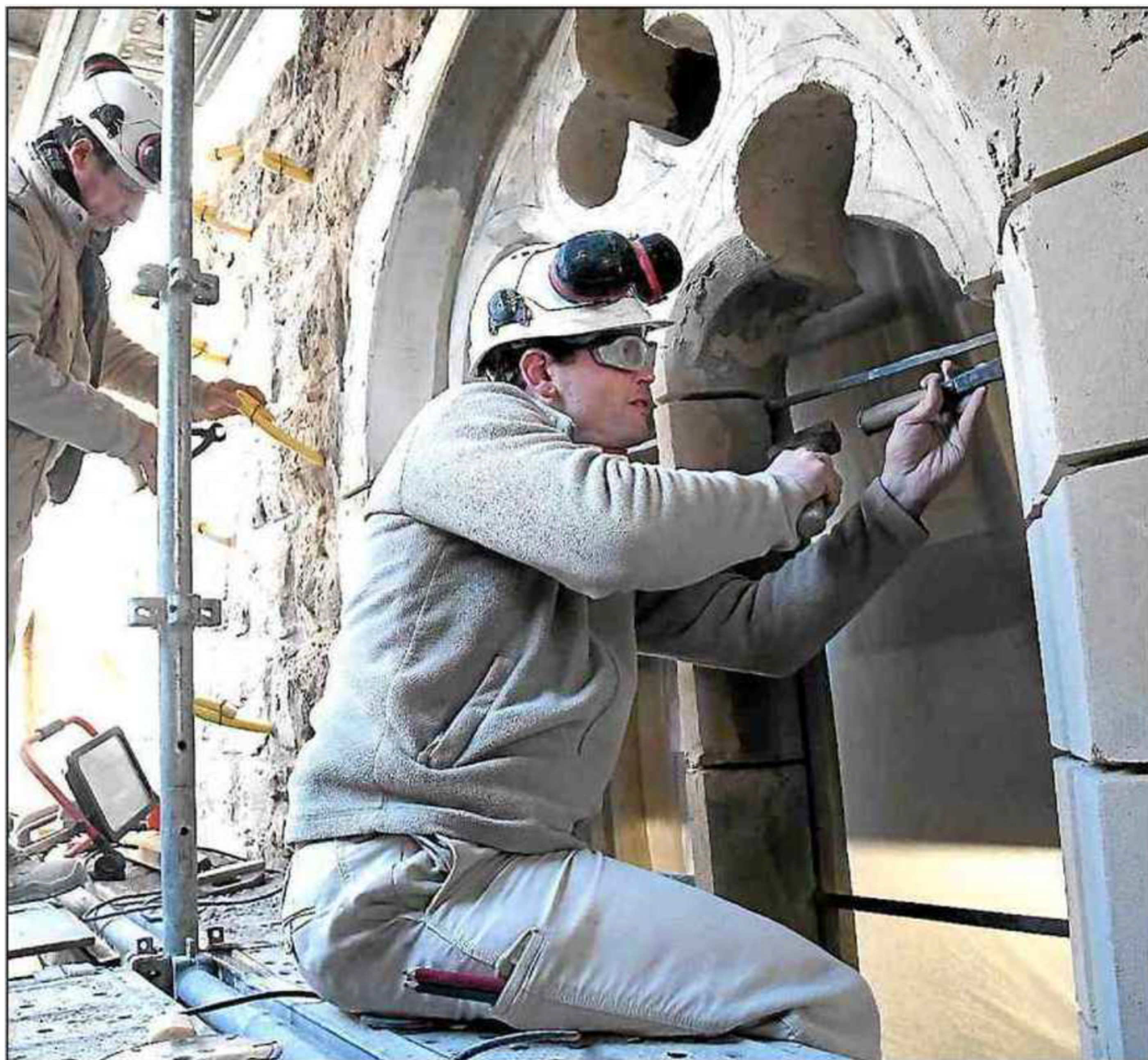
■ L'entreprise Sele en cours d'intervention sur les maçonneries. NATHALIE AMEN VALS
