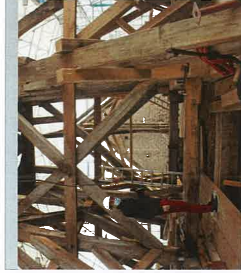
DANS LA CHARPENTE. Les bois de la puissante charpente du XIV e siècle qui porte la flèche de Saint-Maclou ont été largement renouvelés par greffage, lorsque c'était possible. Les madriers qui constituaient le sommet de la flèche, madriers réarmés d'un IPN à l'époque moderne, étaient complètement pulvérisés et ont été intégralement changés.
