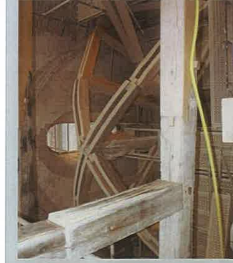
BRAS SUD DU TRANSEPT. Les voûtes sont des structures très plastiques qui supportent des déformations. Celles de la voûte du bras sud étaient telles quelle a été déposée. Les murs reconstruits jusqu'aux arases et les angles renforcés. Il est rare de procéder à une dépose-reconstruction. Ce fut le cas pour les voûtes des chapelles du chœur, tranche I.
