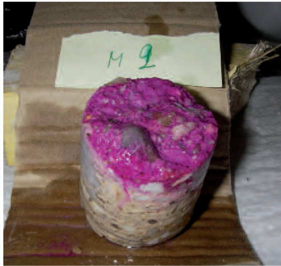
Carottage testé à la phénolphtaléine après traitement
