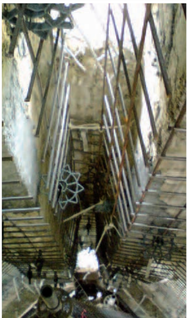
Flocage électrolytique projeté sur le treillis
