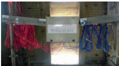
Raccordement des câblages aux borniers d'alimentation
