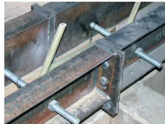
3 - Table de compression bordée par les fers de support du plancher autoportant
