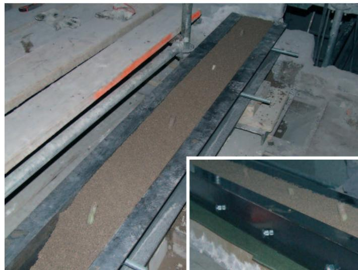
4 - Coulage de la table par un mortier de résine
