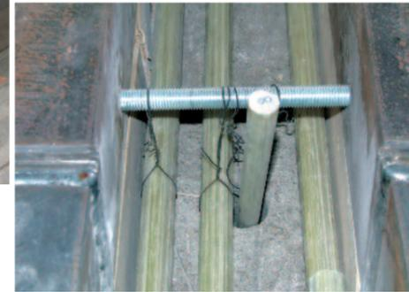
2 - Mise en place des armatures en fibres de verre
