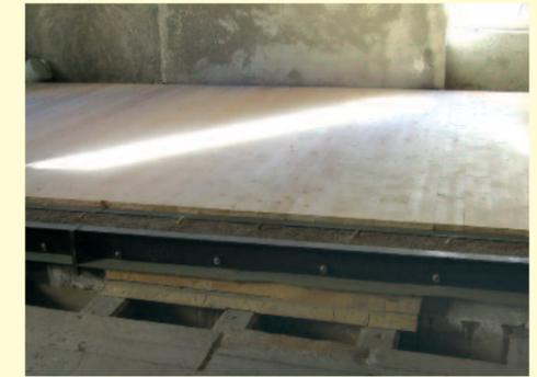
7 - Fers d'appui en attente de la pose de la seconde partie du plancher
