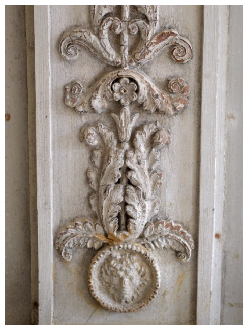
Teinte brun-rouge du ciment naturel prompt apparaissant sous les couches de peinture ; Ornements d'un trumeau de cheminée
