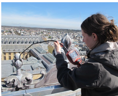
Inspection à l'endoscope avec le pôle métal du LRMH
