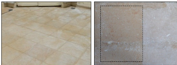
Taches blanches sur le sol dallé et mise au point du protocole de traitement
