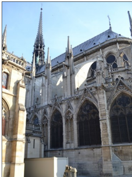
Constat de la dégradation de nombreuses assises de pierre sur l'arc-boutant n°18 de la Cathédrale Notre-Dame de Paris ; visites de carrières
