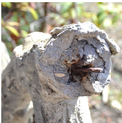
Vue du kiosque à musique et détail du rocaillage ici dégradé
