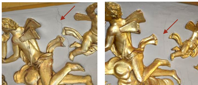
Fissure similaire entre deux moules de décor
