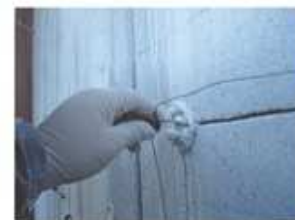
Coulage de la chaîne d'anodes et rebouchage des perçements avec une pâte anodique
