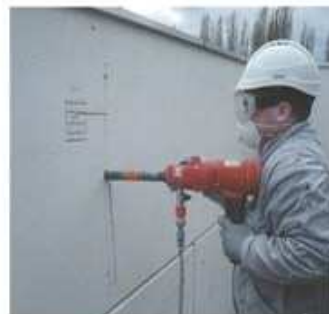
Carottage sous eau pour implantation des anodes
