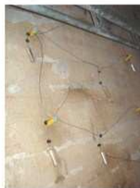
Chaîne d'anodes CPT avant insertion dans les carottages
