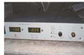
Mise sous tension de la chaîne d'anodes pendant 7 jours
