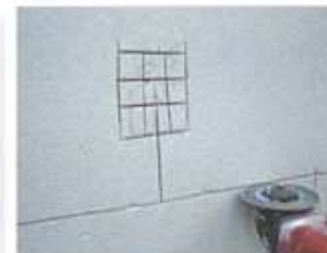
Saignées au disque diamant pour passage du fil titane
