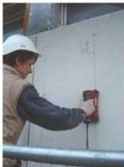
Repérage des aciers au pachomètre pour implantation des anodes
