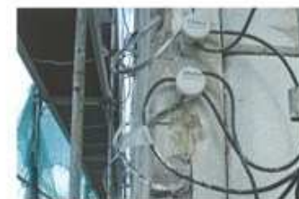
Mise en place des connexions électriques temporaires pour la Phase 1
