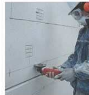
Saignées au disque diamant pour passage du fil titane
