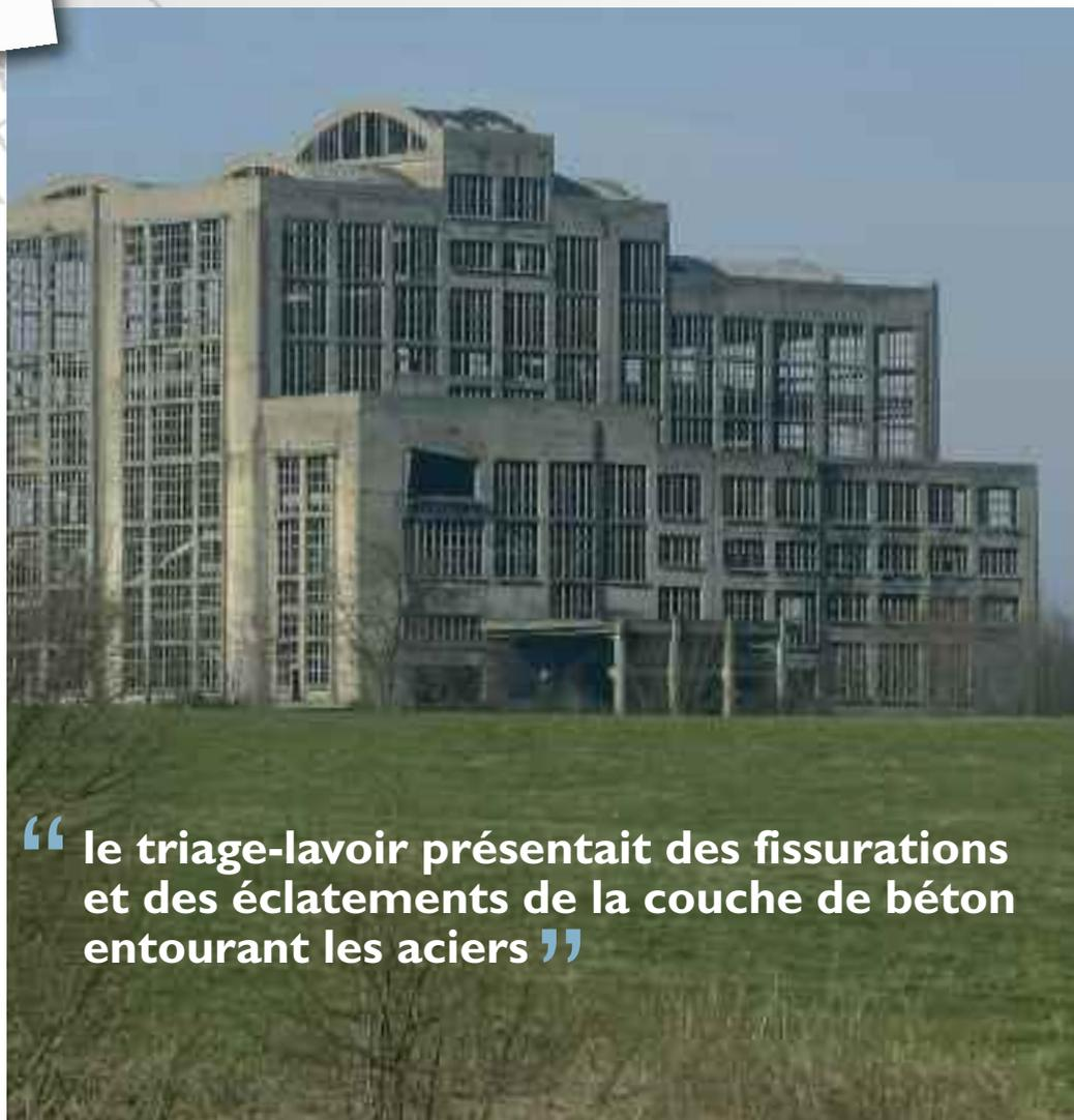
“ le triage-lavoir présentait des fissurations et des éclatements de la couche de béton entourant les aciers ”
