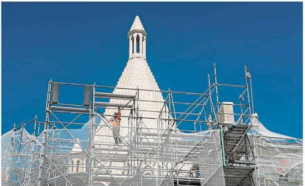
Fontevraud, lundi 27 juillet. Le sommet de pierre des cuisines romanes de l'abbaye a retrouvé sa blancheur immaculée. Le chantier devrait se terminer avant la fin de l'année.
