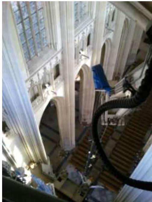
Deux fissuromètres ont été installés à 37,5 mètres de hauteur à l'aide d'une nacelle araignée : sensations garanties !
