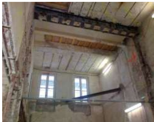
Poutre métallique de reprise pour maintien des étages 3 et 4 ainsi que la démolition des niveaux inférieurs
