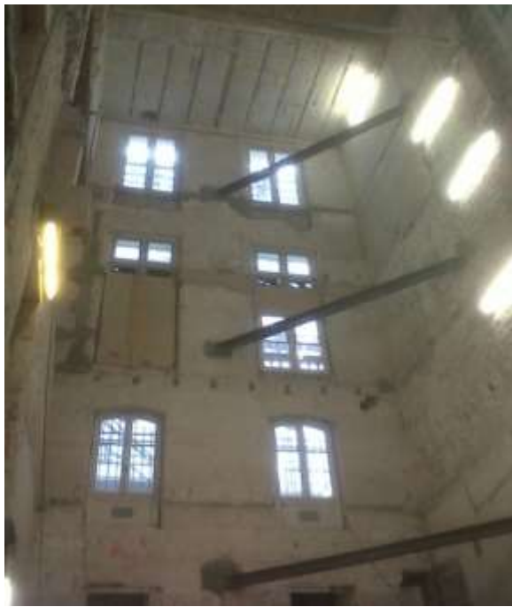
Butonnage de la façade existante conservée
