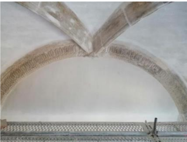
Enduits au mortier de chaux
