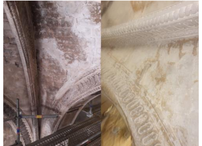
Avant/après Nettoyage des voûtes
