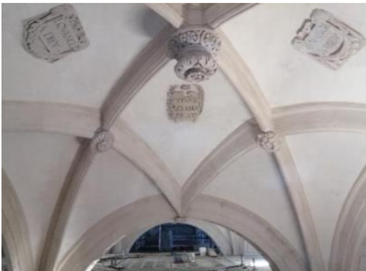
Badigeon des murs et voûtes
