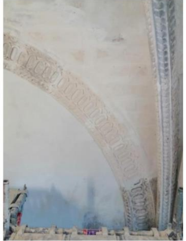
Raccord et retaille des ornements des nervures et jointements
