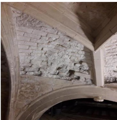
Piochement des enduits
