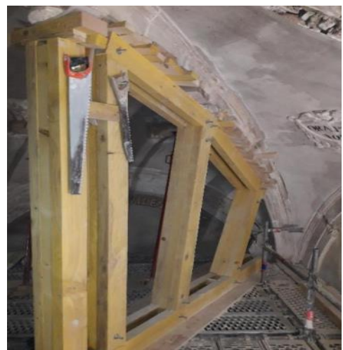
Etaiment pour dépose et repose des nervures des voûtes
