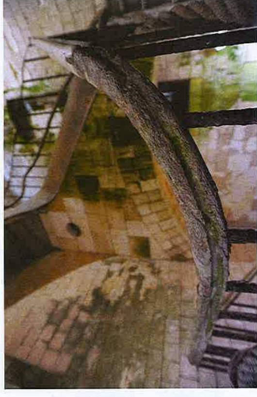
Un escalier en bois monte dans les étages desservant les casemates de jeux, jusqu'à la plate-forme où se tient la vigie
