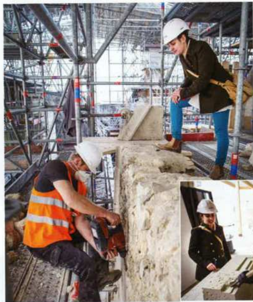
Chantiers. Sur le secteur de La Rochelle, vingt tailleurs et maçons sont à pied d'œuvre, dirigés par Louise Petit, conductrice de travaux.
