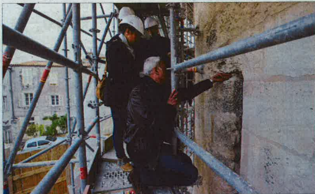
Les travaux de maçonnerie ont duré cinq mois au lieu des douze mois qui auraient été nécessaires. PHOTO XAVIER LEGY
