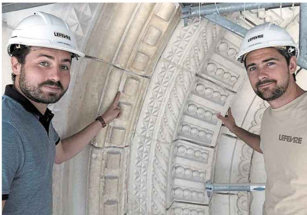
Alexandre Godet, directeur des travaux et Nicolas Poitard, chef de chantier, tous deux tailleurs de pierre.
